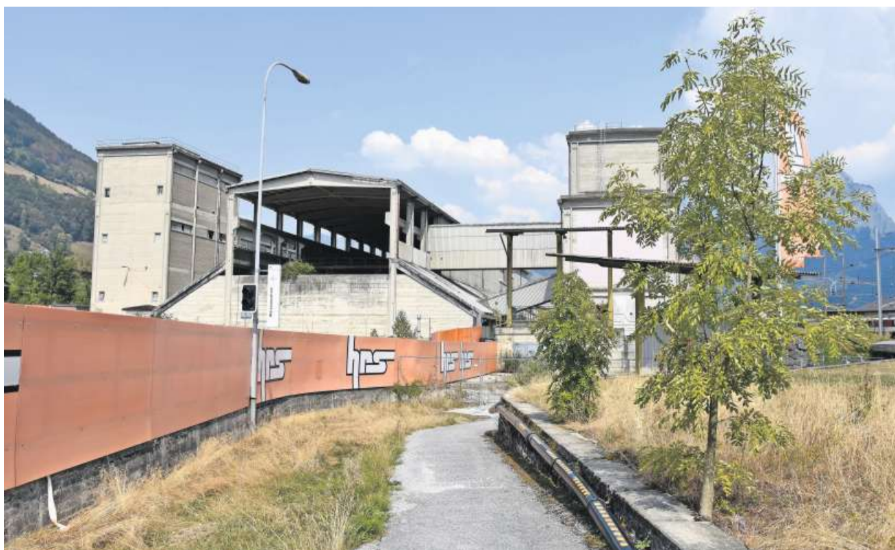
Fast symbolisch steht der erste Baum da: Hier wird eine Boulevard-Allee durch ganz «Nova Brunnen» führen. Bild: JosiasClavdetscher
