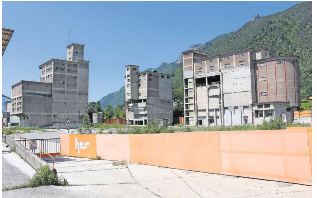
Die beiden Bauten rechts bleiben erhalten, das Gebäude links wird abgerissen.
