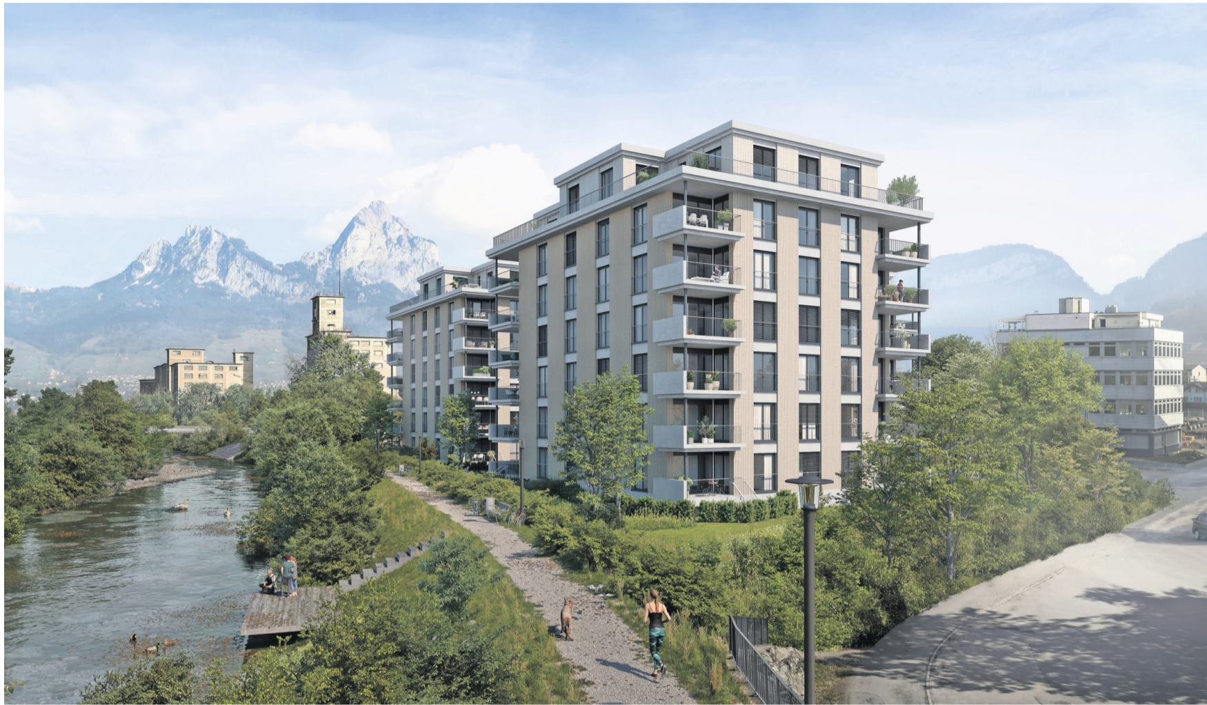
Die erste Etappe von Nova Brunnen, Nova Port, wird neben der Muota auf dem Areal, das dem Dorf am nächsten liegt, gebaut.
